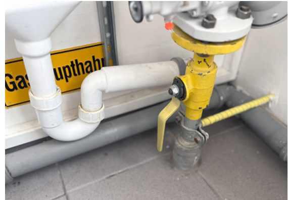
Haupt-Absperreinrichtung am Hausanschluss
