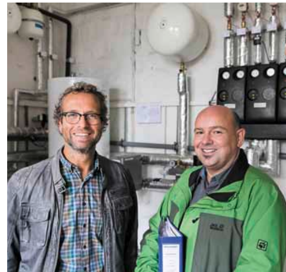
Gärtnermeister Michael Möbius (links) ist zufrieden: René Beck, Projekttingenieur der Ohra Energie, bei der Übergabe der neuen Wärmeerzeugungsanlage. Mehr dazu auf den Seiten 4/5.
